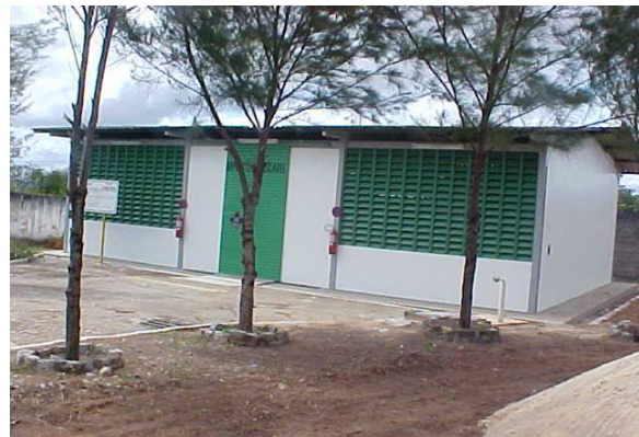
FIGURA 1-d - Depósito de Fortaleza/CE
