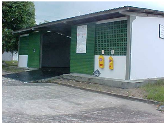
FIGURA 1-b - Depósito de Camaçari/BA
