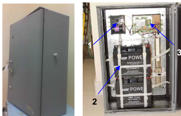
Figura 3. Interior da UR do Protótipo Flashover 500kV-V01. (1) Módulo da antena do celular e bateria auxiliar da unidade microprocessada; (2) Banco de baterias (duas baterias ligadas em paralelo de 12V@44Ah); (3) Unidade microprocessada mais módulo celular.
