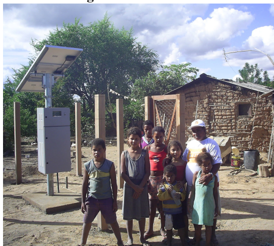
Figura 7 – Sistemas Residenciais Típicos SIGFI13 – Programa Luz para Todos, instalado na área de concessão da Cemig
