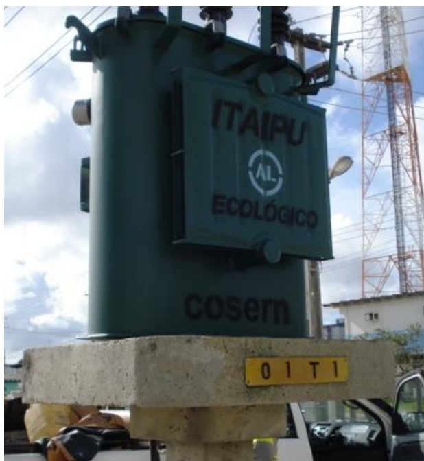
Figura 4 – Transformador novo como mistura de óleos.
