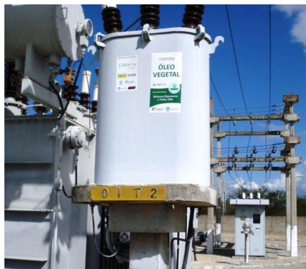
Figura 3 – Transformador posição 01 T 2 – SE Maísa
