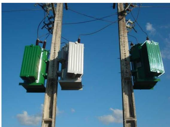
Foto 6 – Banca reguladora instalada em campo.
