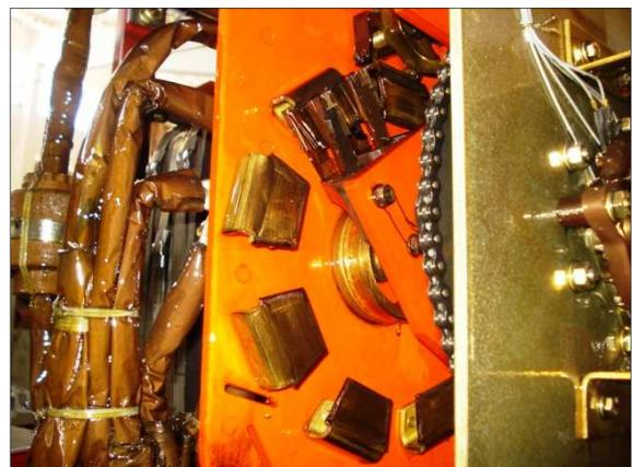
Foto 12 – Contatos - Pólo com fluido isolante 100M.
