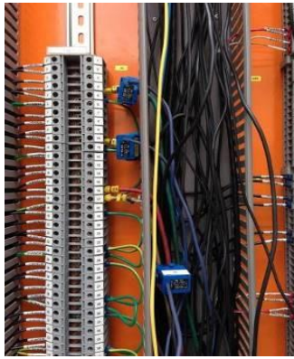
Figura 10. Instalação dos TCS-alcates nas fases A, B e C do transformador.
