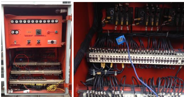
Figura 3. Instalação do transdutor de corrente na fase A do transformador reserva.
