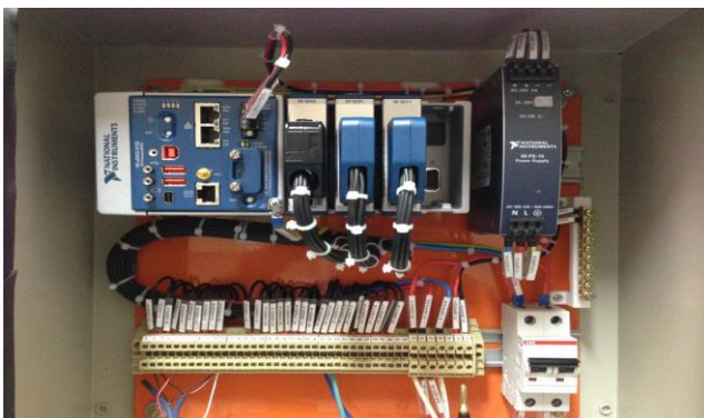
Figura 9. Controladora CompactDAQ - 9132 e módulos de corrente, tensão e temperatura no interior do Painel Coletor de Dados.
