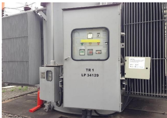
Figura 13. Instalação do Painel Coletor de Dados.
