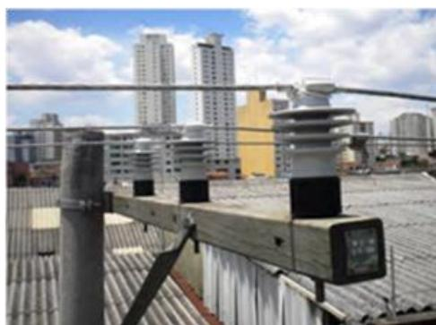
Figura 7 - Três unidades de isoladores protótipos instalados, fixação do cabo com fio de alumínio.
