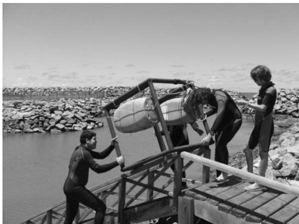
Figura 3. Instalação do protótipo do recife no canal de captação de água da TERMOPE.
