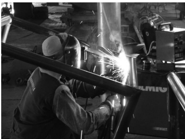
Figura 4. Construção das estruturas metálicas para servirem como recifes artificiais em Suape.
