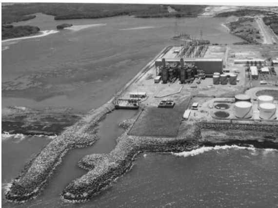
Figura 1. Vista geral da TERMOPE e o seu canal de captação de água em Suape.
