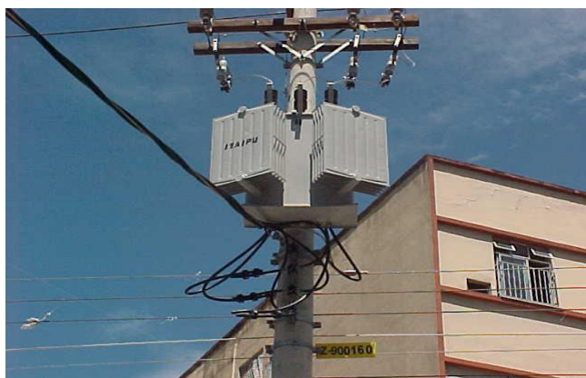
Figura 11. Foto da instalação do equipamento na rede de distribuição
