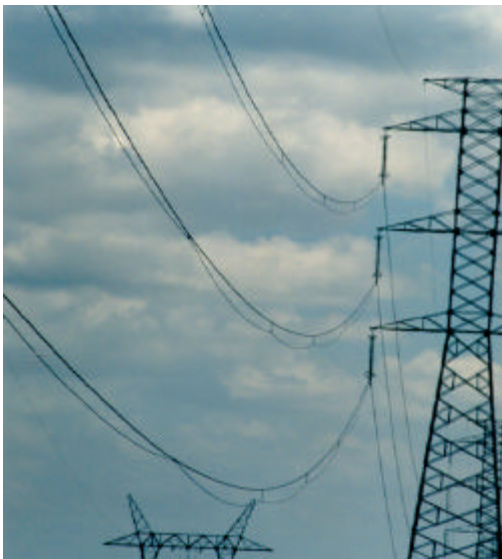
FIGURA 2 – Emprego de cabo auxiliar em LT existente – LT Piloto da CHESF – cabo auxiliar 4/0 AWG
