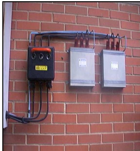
Figura 3 – instalação sem caixa de proteção
