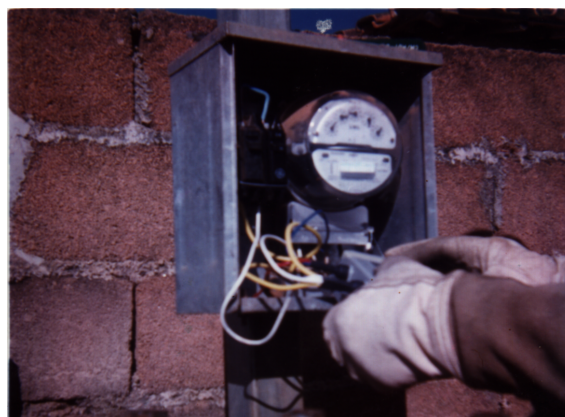
Foto 1 - Interior da Caixa de Medição e Proteção - Instalação do Módulo
