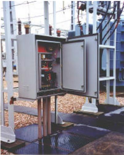
FIGURA 7 - UNIDADE DE AQUISIÇÃO DE DADOS
