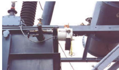
FIGURA 5– SUBSISTEMA DE MONITORAMENTO DE TEMPERATURA
