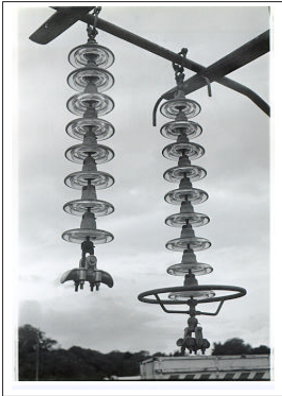
Comparativo entre os comprimentos das cadeias de suspensão nova e antiga.
