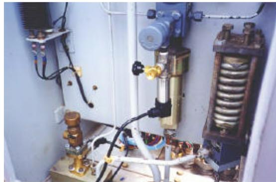
FIGURA 7 – SENSOR DO SISTEMA DE AR COMPRIMIDO
