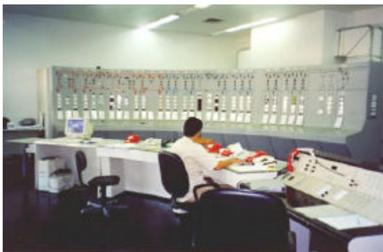
FIGURA 10 – SALA DE COMANDO DA SE CABREÚVA, COM O MONITOR AO FUNDO
