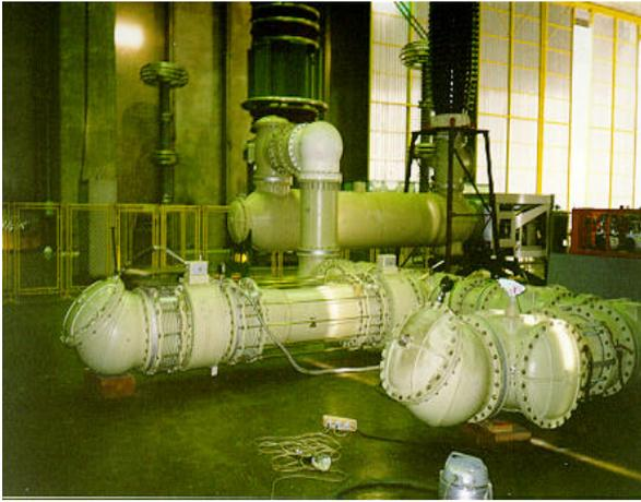
Foto 1 - Trecho de instalação blindada isolada à gás SF<sub>6</sub> montado em ITAIPU
