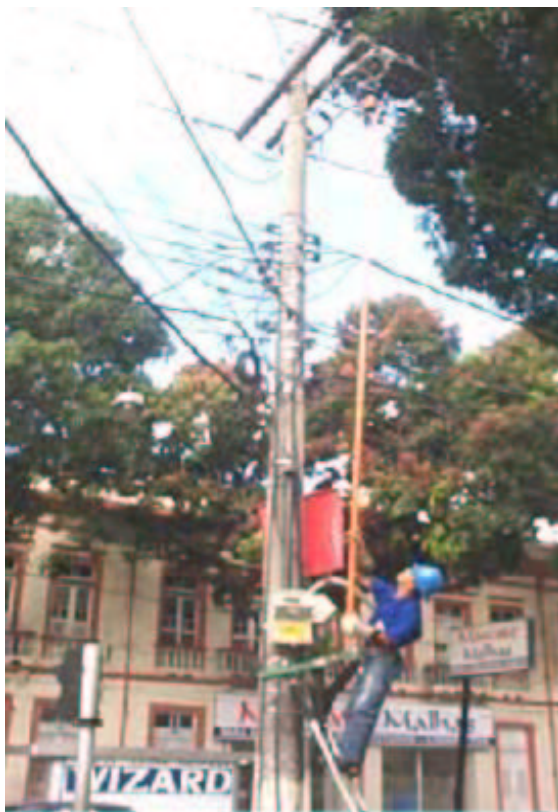
Fig. 03 – Intervenção em Alta Tensão
