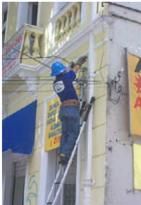
Fig. 04 – Intervenção em Baixa Tensão
