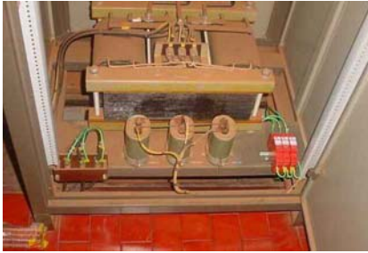
FIGURA 13 – Proteção do retificador (uscc)
