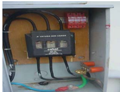
FIGURA 15 – Proteção do qm
