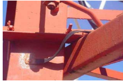
FIGURA 4 – Aterramento do esteiramento
