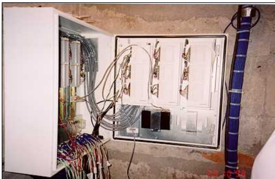
Foto 02 - Unidade de Medição e Controle (MCU) – Foto da sua Instalação.
