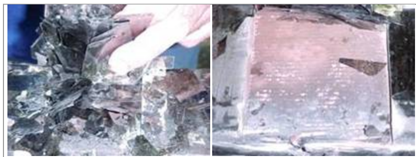
FIGURA 7 – Desagregação da mica e ponto da falha para a terra.
