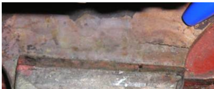
FIGURA 13 – Detalhe da trinca
