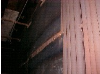
FIGURA 9 - detalhe da chapa defletora no aquecedor de ar da caldeira
