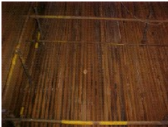
FIGURA 7 - foi aberta a chaparia da caldeira onde os tubos estavam desalinhados para possibilitar o reposicionamento e depois foram recompostos o isolamento térmico e a chaparia.
