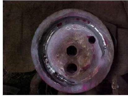
FIGURA 5 – (b) tampo do coletor em reparo (leste)
