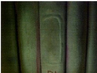
FIGURA 6 - foi removida uma parte do tubo onde se encontrava a “laranja“ ( janela ) e instalado “insert metálico”.
