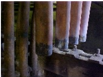
FIGURA 8 - para melhor avaliar as serpentinas dos superaquecedores, foi retirado um “ loop “ da serpentina para análise. Foi repostos um novo “ loop “ para manter as condições originais da caldeira.
