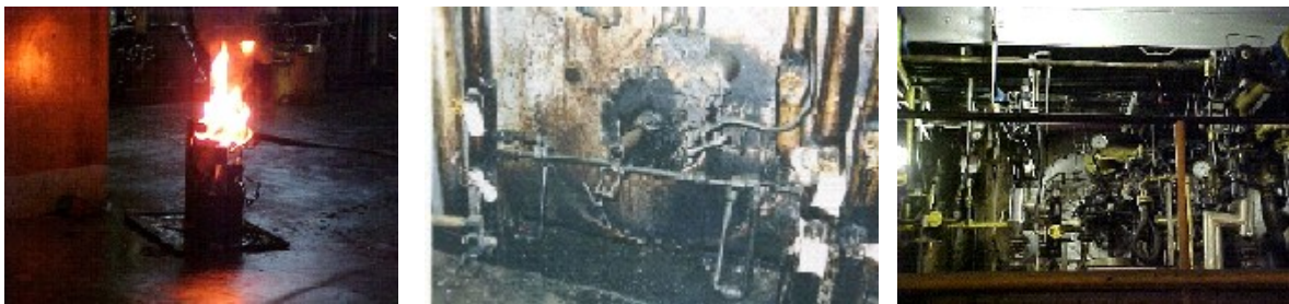
FIGURA 3 - frontal do queimador original da montagem da usina (detalhe - tocha para acendimento) e do novo queimador
