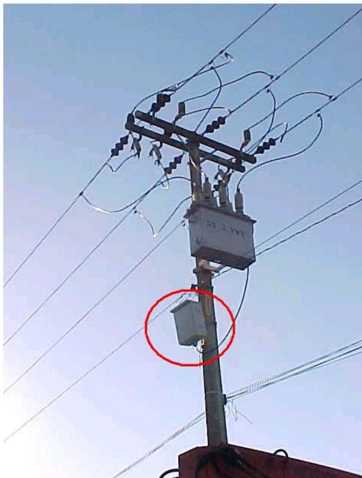
**Figura 8 – Religador com retrofit instalado na rede.**
