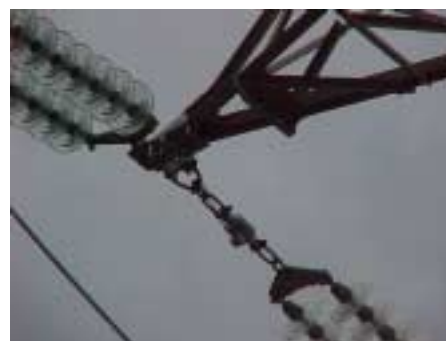
Figura 4. Instalação do Sensor de Carga
