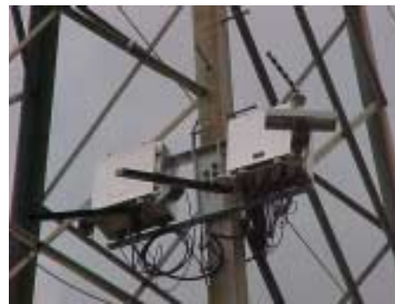
Figura 5. Detalhe da Instalação do CAT1 na Estrutura 34 da LT Neves 1-2, 138 kV
