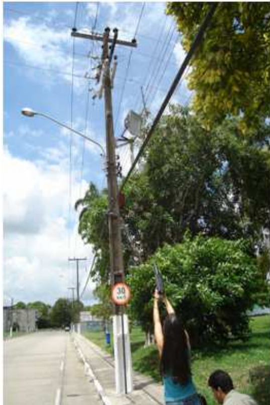
Figura 27 – Inspeção de ultra-som em campo
