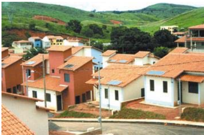
FIGURA 6 - COHAB - Companhia de Habitação Minas Gerais, Governador Valadares/MG Uso doméstico Projeto desenvolvido pela ABRAVA e Agência Energia.
