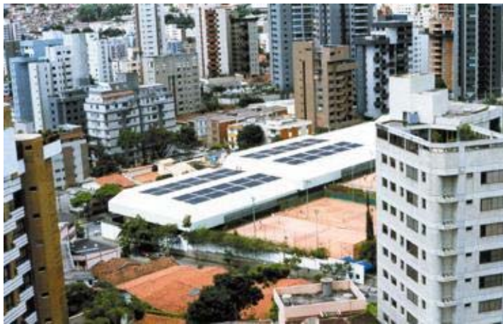
FIGURA4 - Minas Tênis Clube Unidade II/MG Belo Horizonte/MG Aquecimento de quatro piscinas semi-olímpicas Projeto desenvolvido pela CEMIG e Agência Energia.
