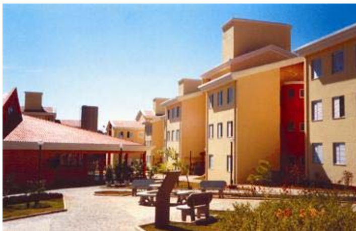
FIGURA5 - Moradia Estudantil UFMG Belo Horizonte/MG Uso doméstico Projeto desenvolvido por CEMIG e Agência Energia.
