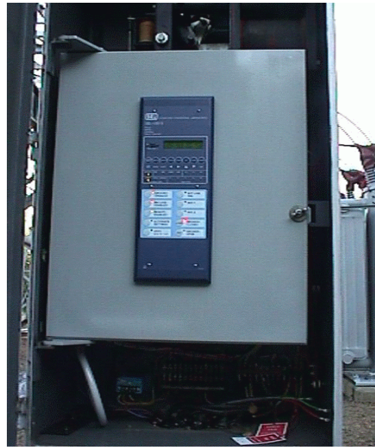
Figura 4 – Relé Convencional x Digital
