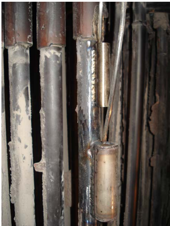
Figura 8. Sensor aterrado (superior) e sensor blindado (inferior) instalados no 20° tubo do superaquecedor final.
