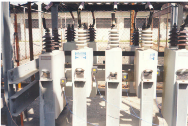
Figura 4 - Bancos de capacitores com os sensores acústicos instalados
