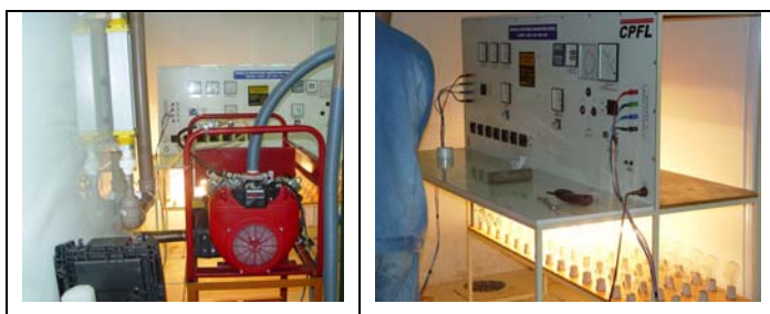
Figura 10 Operação do moto-gerador com gás de biomassa
