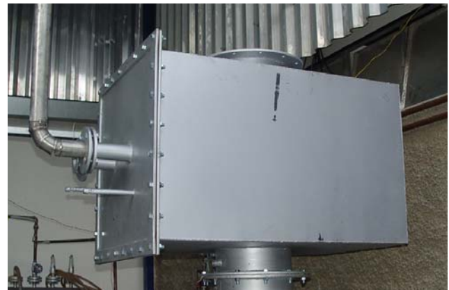
Figura 3. Reator Catalítico
