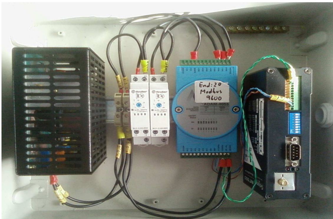
Figura 7 – Montagem do sistema de acionamento da chave a óleo
