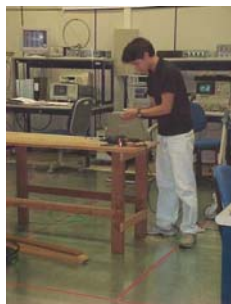
Figura 3 - Vista da construção da bancada de ensaios
