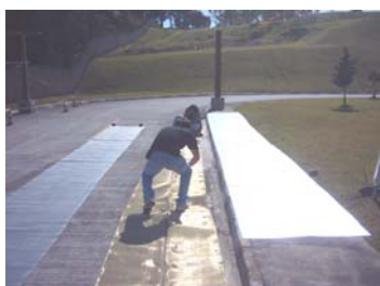
Figura 15 - Corte da tela para a construção da blindagem
