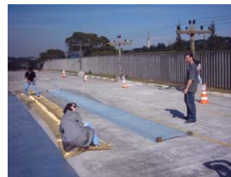
Figura 16 - Corte das telas para a construção das blindagens
