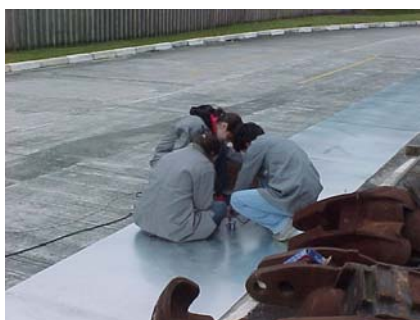
Figura 5 - Construção do plano metálico
