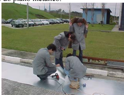
Figura 4 - Construção do plano metálico
