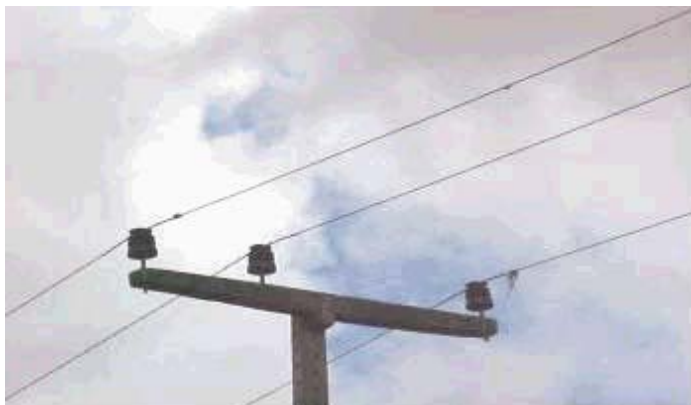
FOTO 9 – Rede de Distribuição Após a Limpeza
