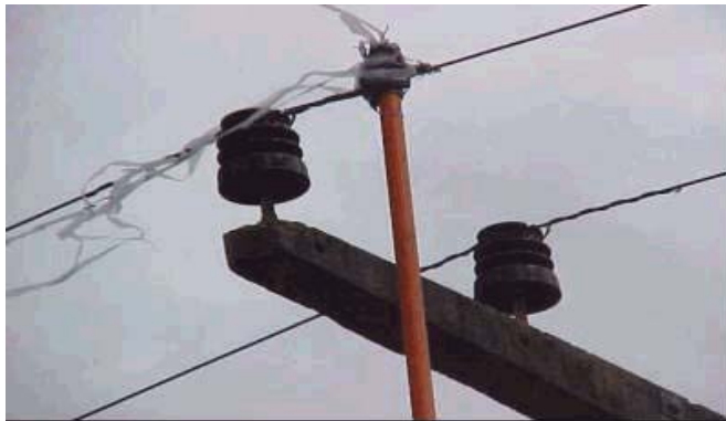
FOTO 7 – Ação do Equipamento no Ato da Limpeza
