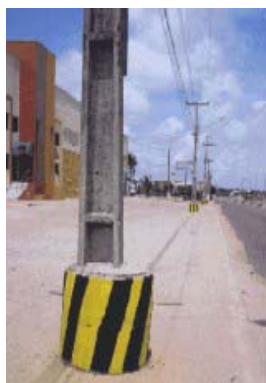
FOTO 1 - Defesa em Poste
