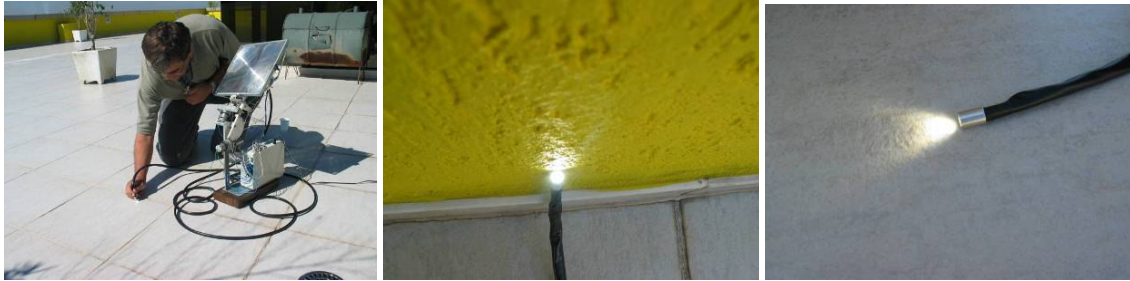
Figura 12 – Primeiro ensaio de campo mostrando detalhes da extremidade da fibra iluminada
