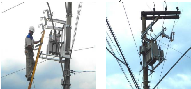
Figura 5: Instalação do Banco em Vinhedo
