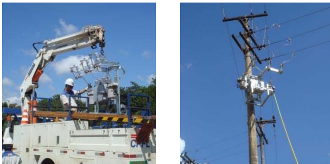
Figura 4: Instalação do Banco Sertãozinho
