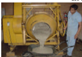
Fotografia 2 – Aspecto do Concreto
