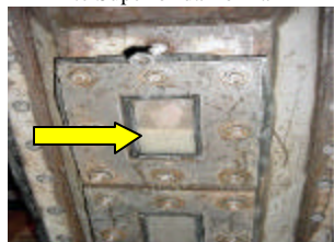
Fotografia 13 - Enchimento da Fôrma com Concreto Sob Pressão 9 kgf/cm 2
