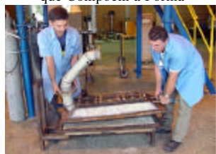
Fotografia 11 - Colocação da Parte Superior da Fôrma
