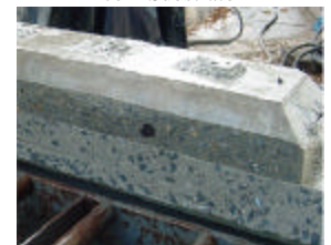
Fotografia 14 - Desforma com Clara Distinção entre os Concretos
