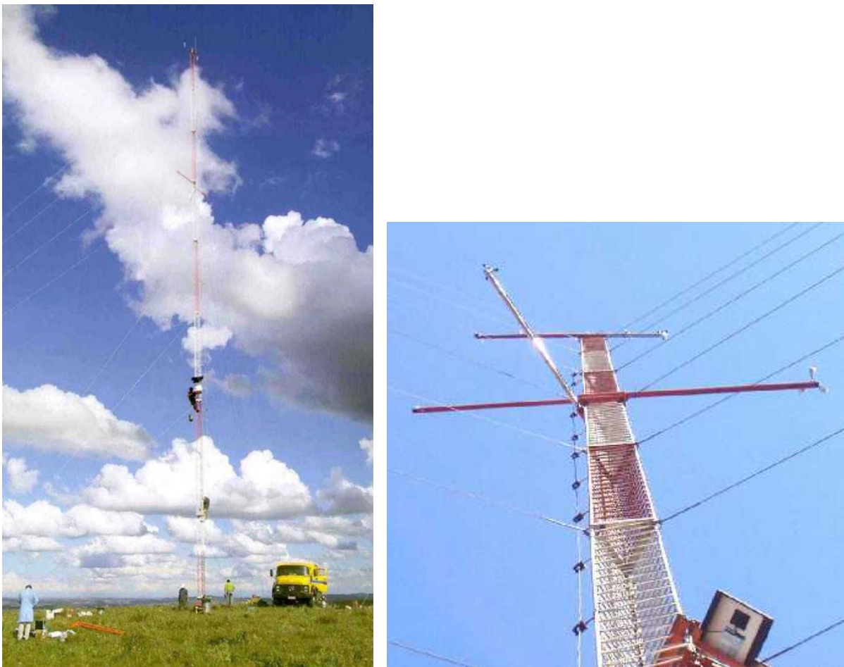
FIGURA 1: Torre de monitoramento 01-Taquara, com 50m de altura.
