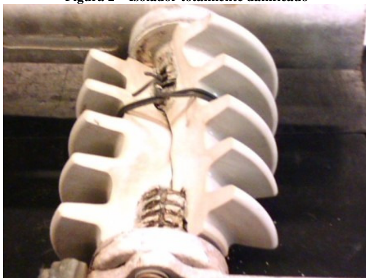
Figura 2 – Isolador totalmente danificado
