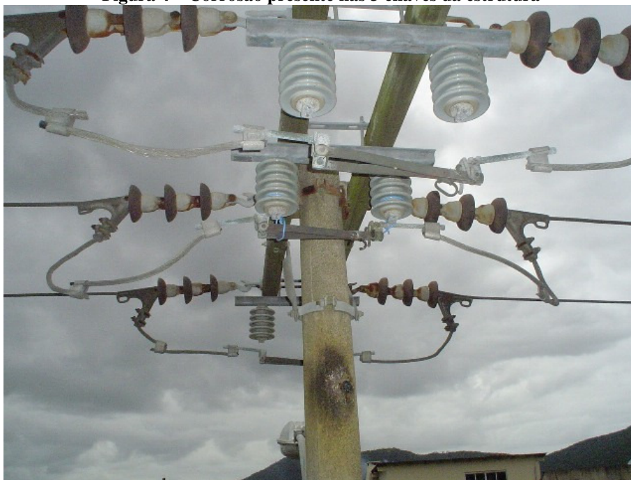
Figura 4 – Corrosão presente nas 3 chaves da estrutura
