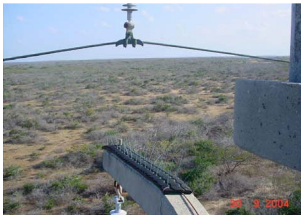
Figura 3 – Aplicação de solução a base de borracha e pregos.
