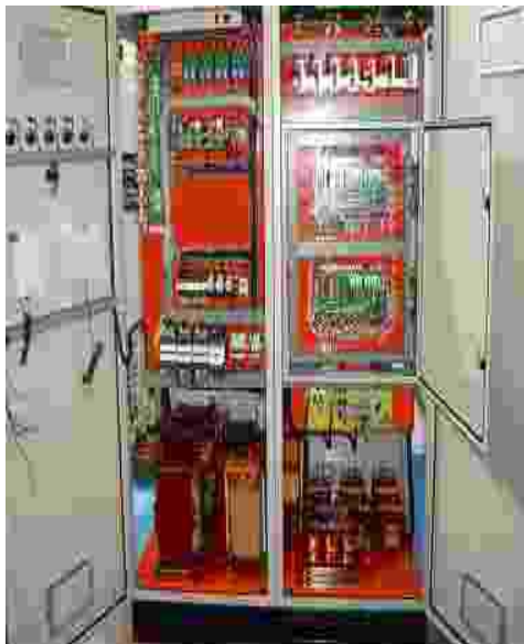
Figura 9. MDVR-02 – Vista frontal (Transformadores de Injeção, Filtro de saída, Placas de interface e Proteções)
