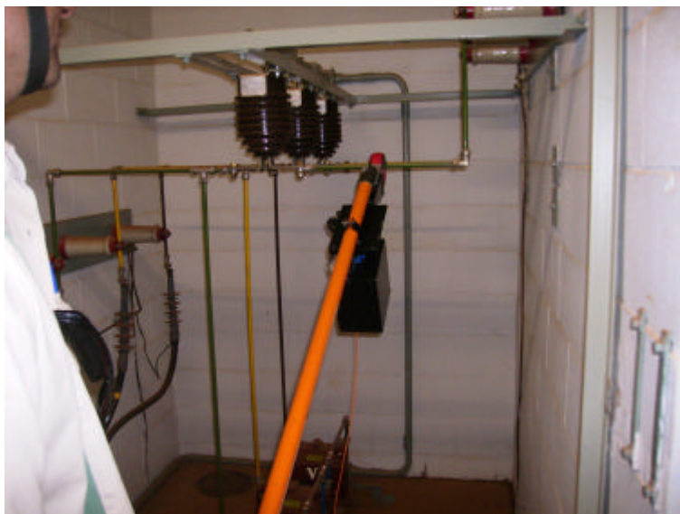
Figura 10. Verificação de TCs em instalação consumidora de MT
