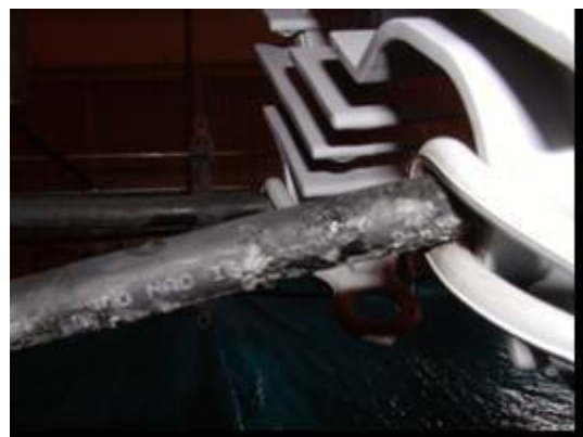
Figura 3. Trilhamento elétrico e erosão no cabo protegido.
