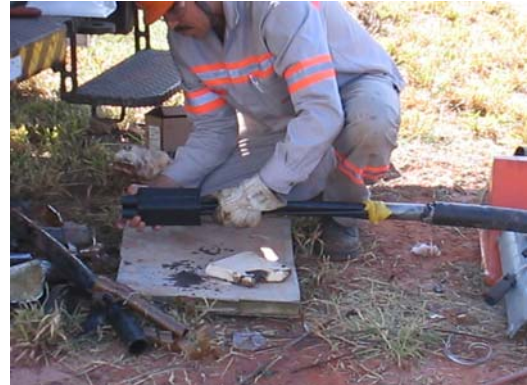
Figura 3. Preparação para confecção de uma emenda de transição.
