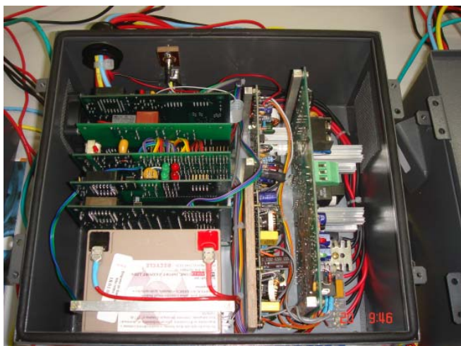
Figura 2 – Ilustração do módulo GEMOREL com todas as placas montadas e bateria.
