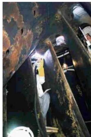
Fig. 1- Soldadores entre as pás de uma turbina hidráulica da Unidade Geradora de Salto Santiago –
