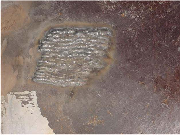
Fig. 14 – Depósito de ER 309-L Realizado em campo, com corrente contínua constante
