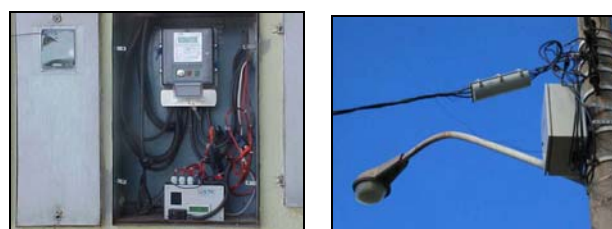
Figura 15. (a) RX e (b) TX instalados.
