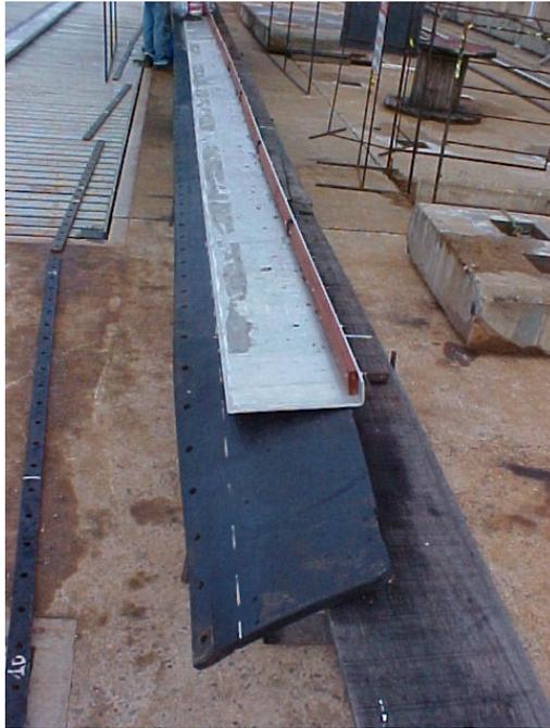
FIGURA 9– Montagem da borracha, chapas de aço inoxidável e raspador da vedação
