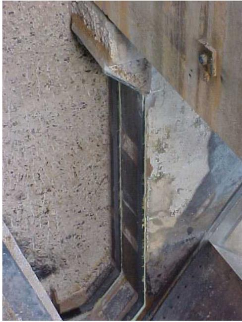
FIGURA 5– Nicho para a instalação das vigas espelho
