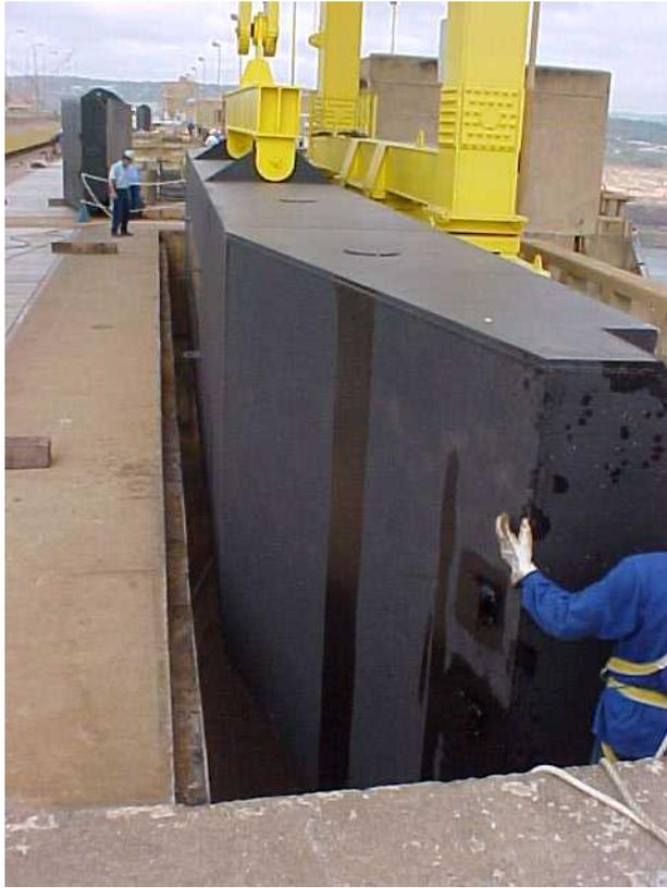
FIGURA 7– Instalação da viga espelho
