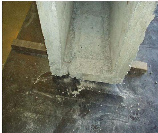
FIGURA 6 – PEDAÇO DO CONCRETO QUE “EXPLODIU”, DANIFICANDO A CANALETA
