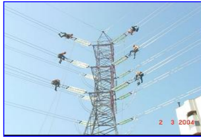
FIGURA 4 – Emprego dos Cabo Invar e Termorresistente
