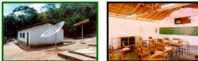
Figura 2 – Exemplo de escola eletrificada com sistemas fotovoltaicos pelo LUZ SOLAR – fase 1.
