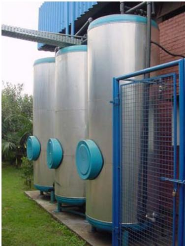
Foto 6 – Tanques isolados e aquecimento suplementar a gás
